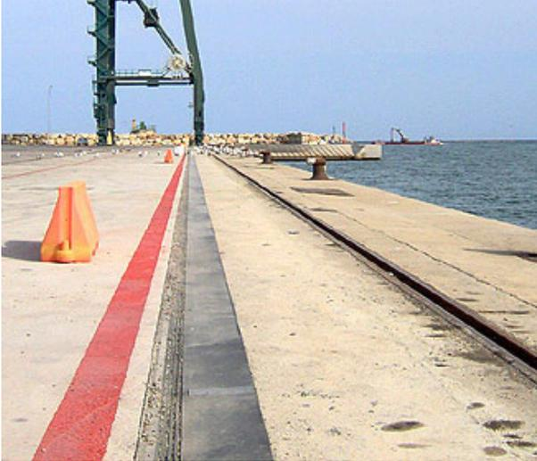
Auxema Stemmann dispone de diferentes tipos de canales dependiendo del tipo de instalación y el tipo de ejecución móvil.
